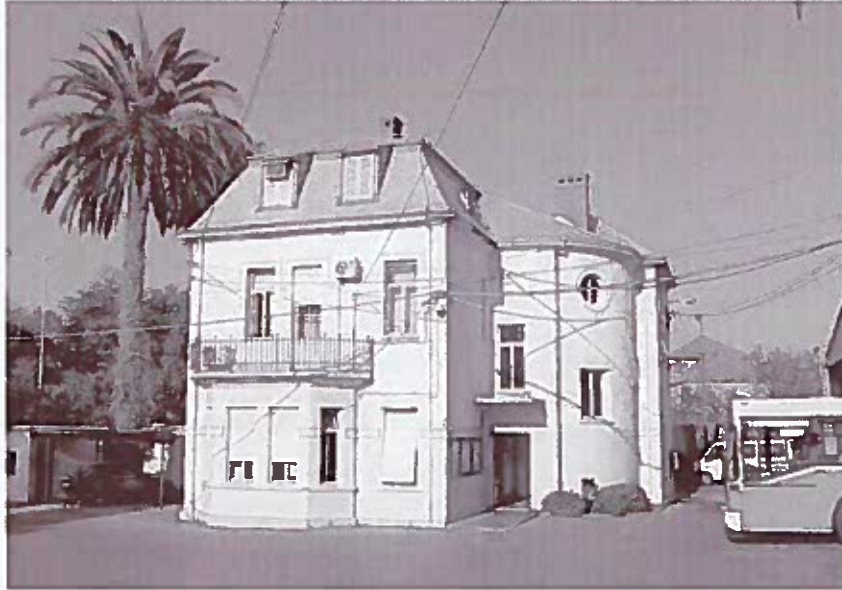
Slika 5. Upravna zgrada „Dubrovačke električne željeznice“, Dubrovnik Stanje prije rušenja, foto A. Baće, City in the Making, kvartal XIV -1 | 2-2017
