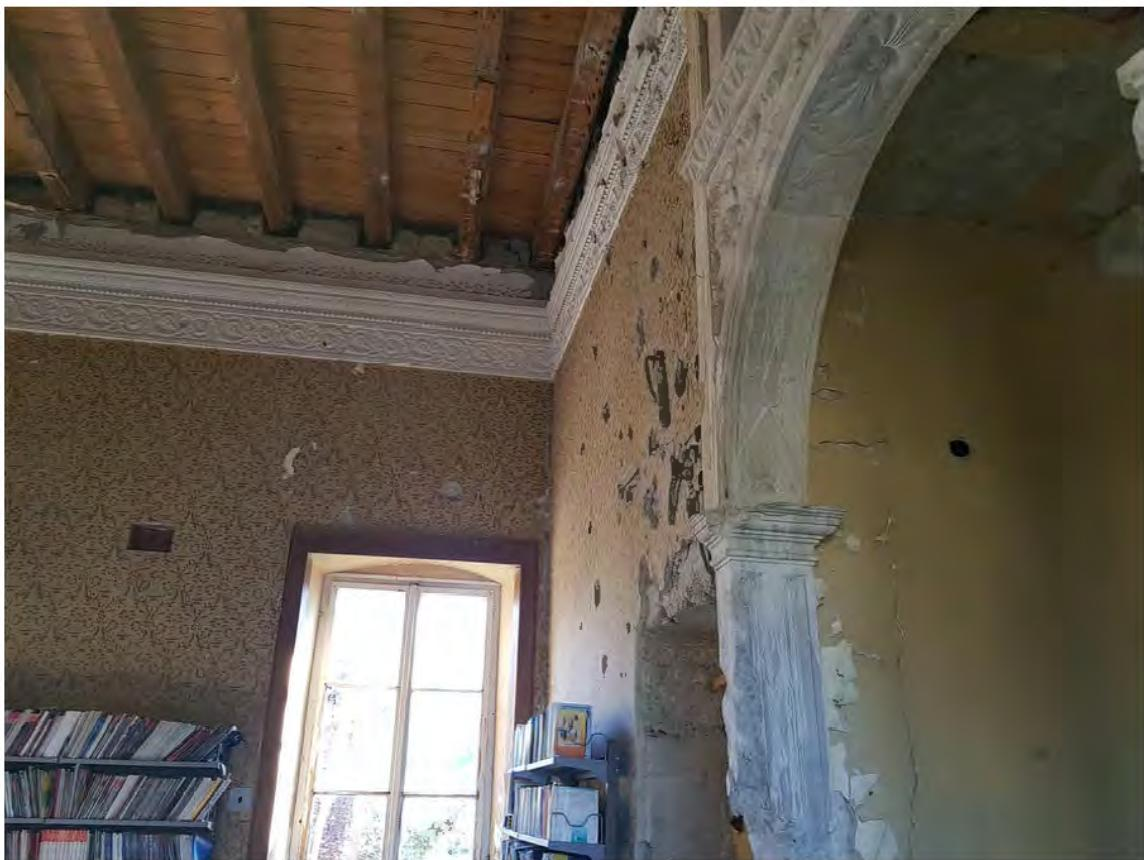
Slika 18. Oštećenja na zidovima i nosivoj krovnoj konstrukciji unutar salona na katu
