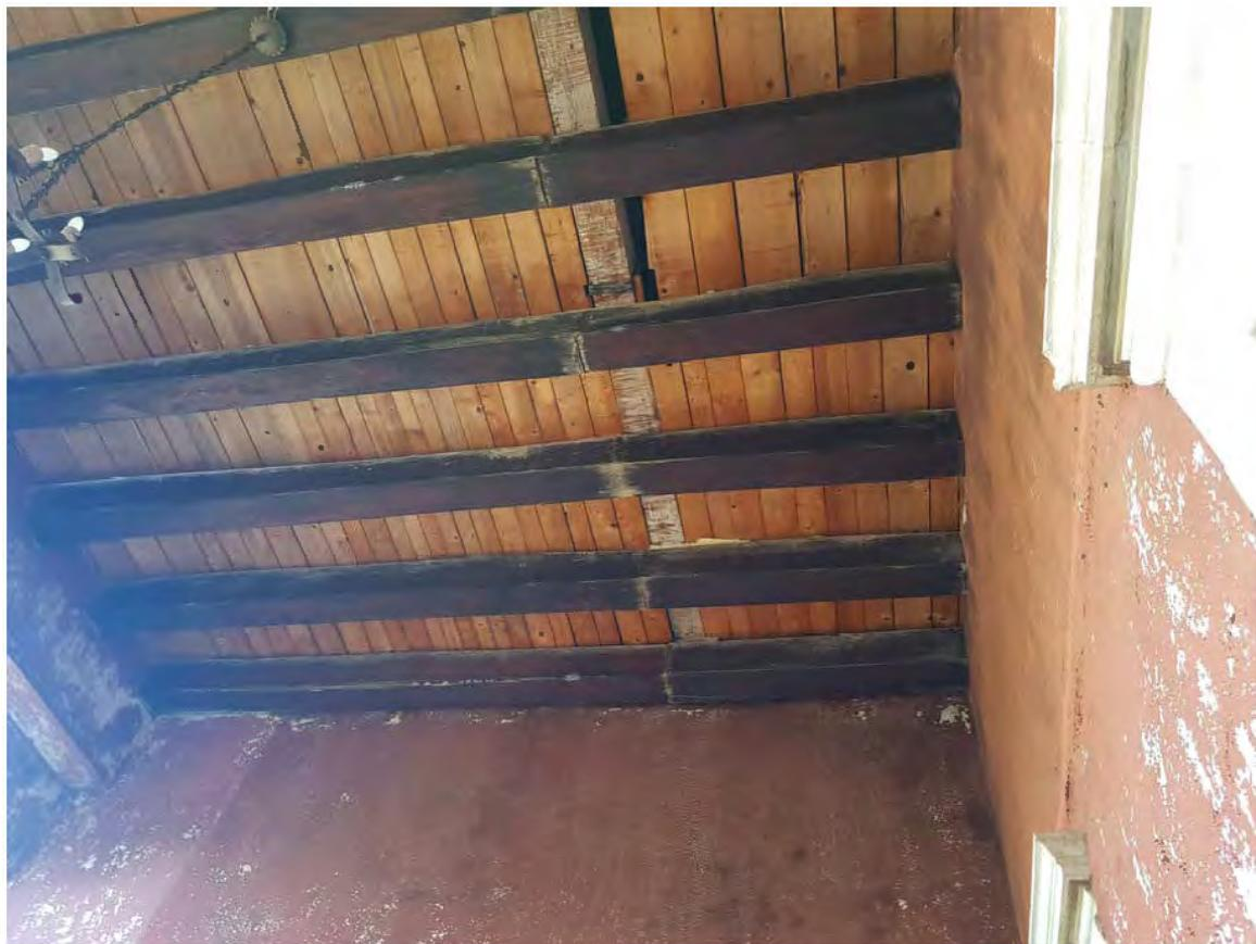
Slika 29. Oštećenja na stropnoj/krovnoj konstrukciji lođe na katu
