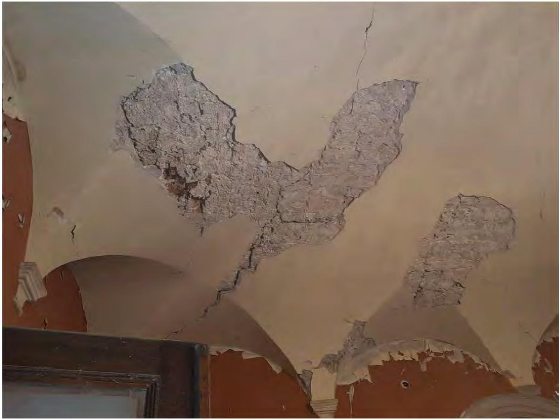
Slika 5. Oštećenje stropne konstrukcije unutar salona u prizemlju
