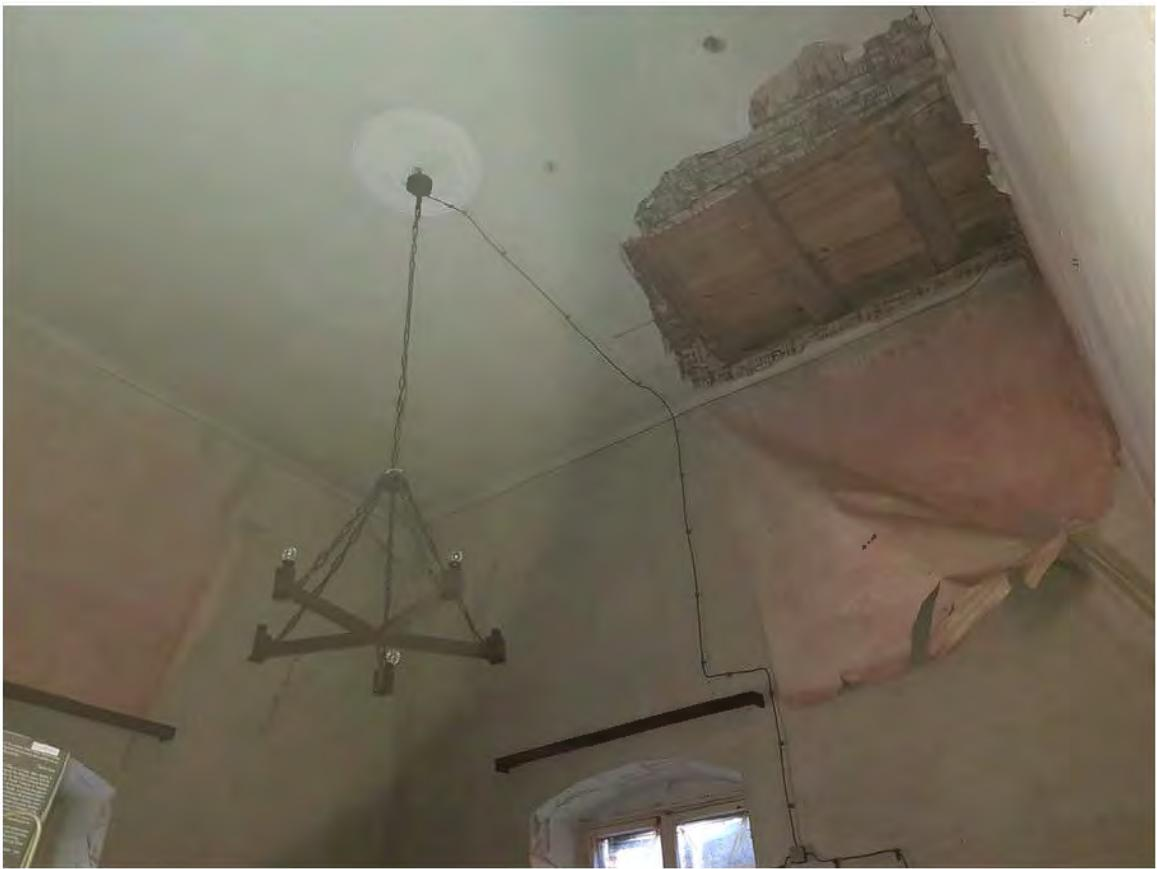
Slika 23. Vlaga i oštećenja na zidovima i stropu unutar sobe za upravu na katu
