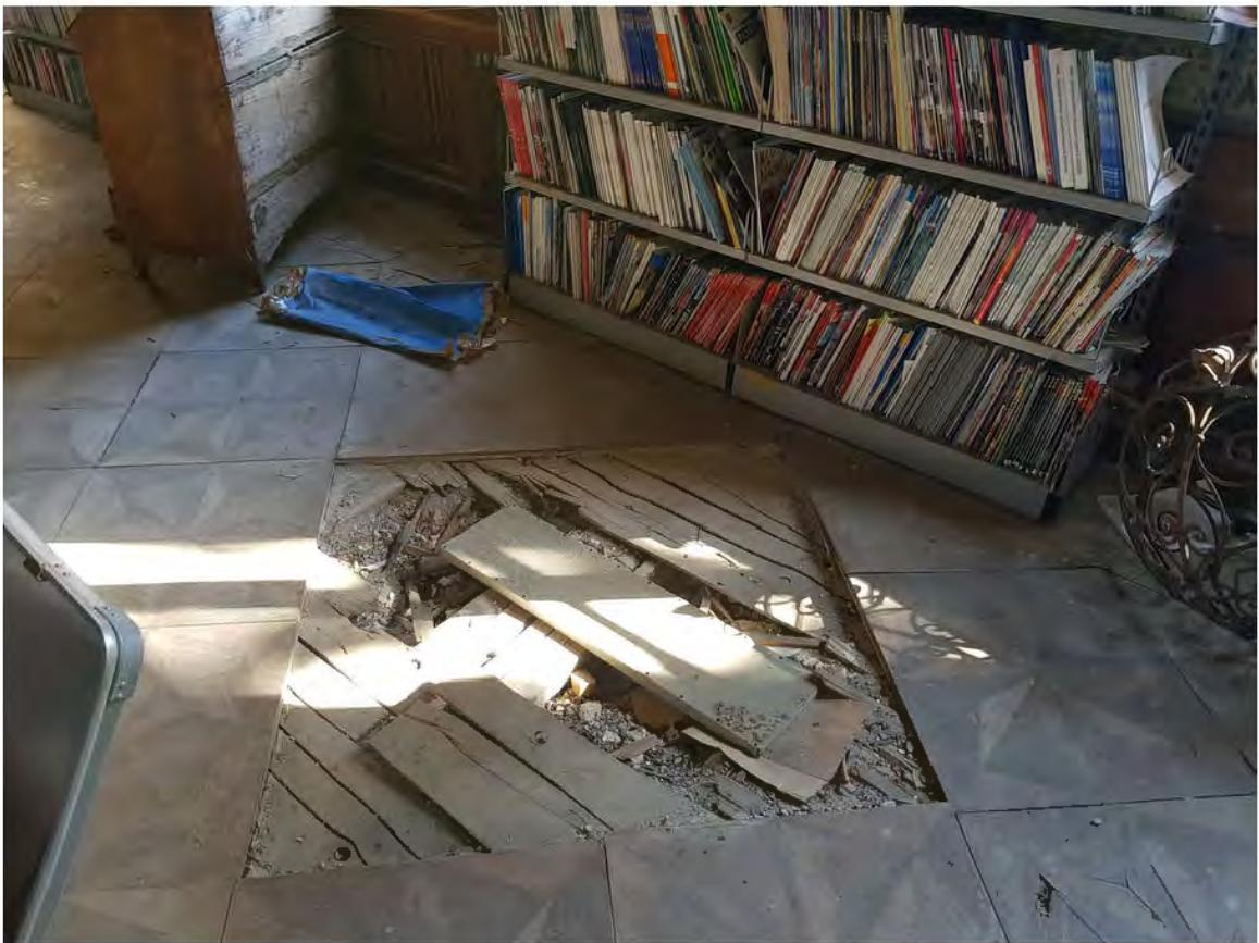
Slika 21. Oštećenja na podnoj drvenoj konstrukciji unutar salona na katu
