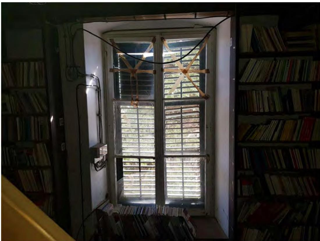
Slika 27. Oštećenja na prozoru unutar čitaonice na katu
