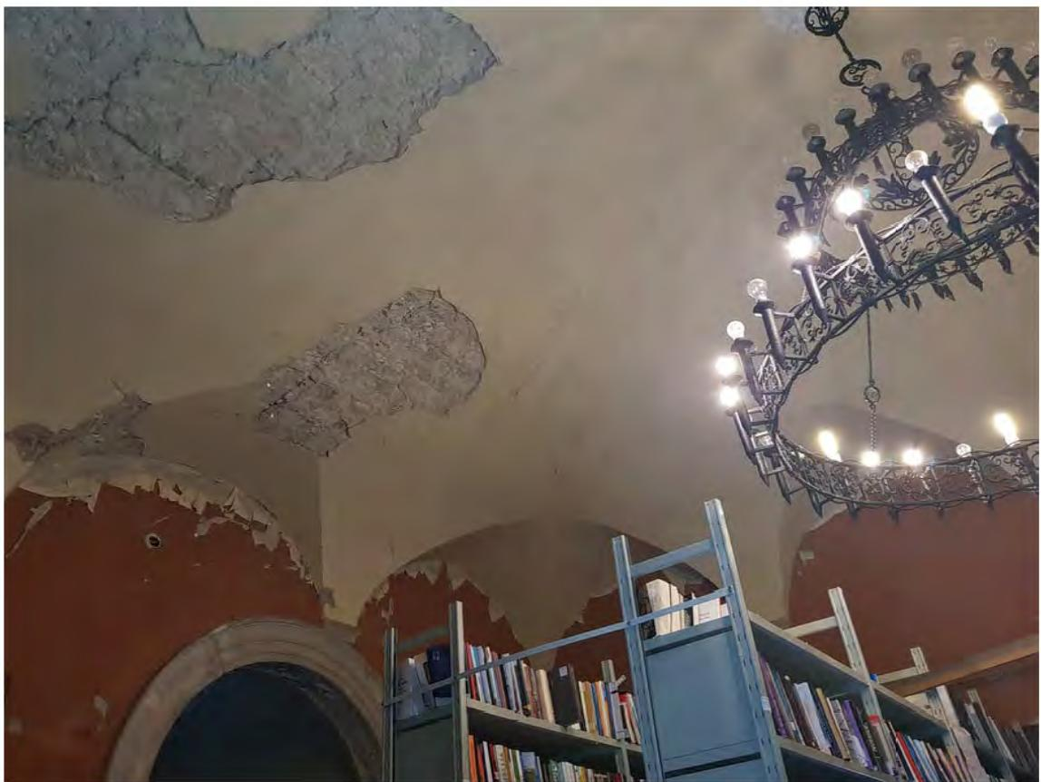
Slika 6. Oštećenje stropne konstrukcije unutar salona u prizemlju
