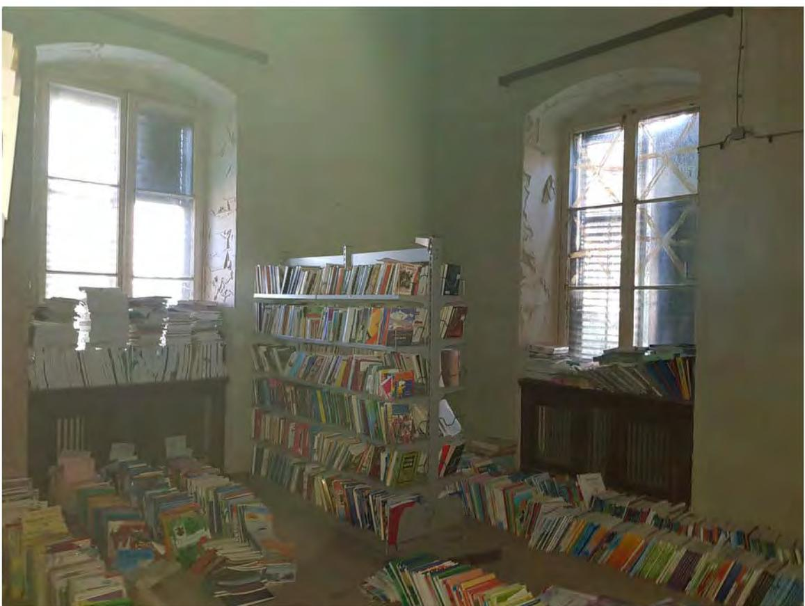
Slika 24. Vlaga i oštećenja na zidovima i prozorima unutar sobe za upravu na katu
