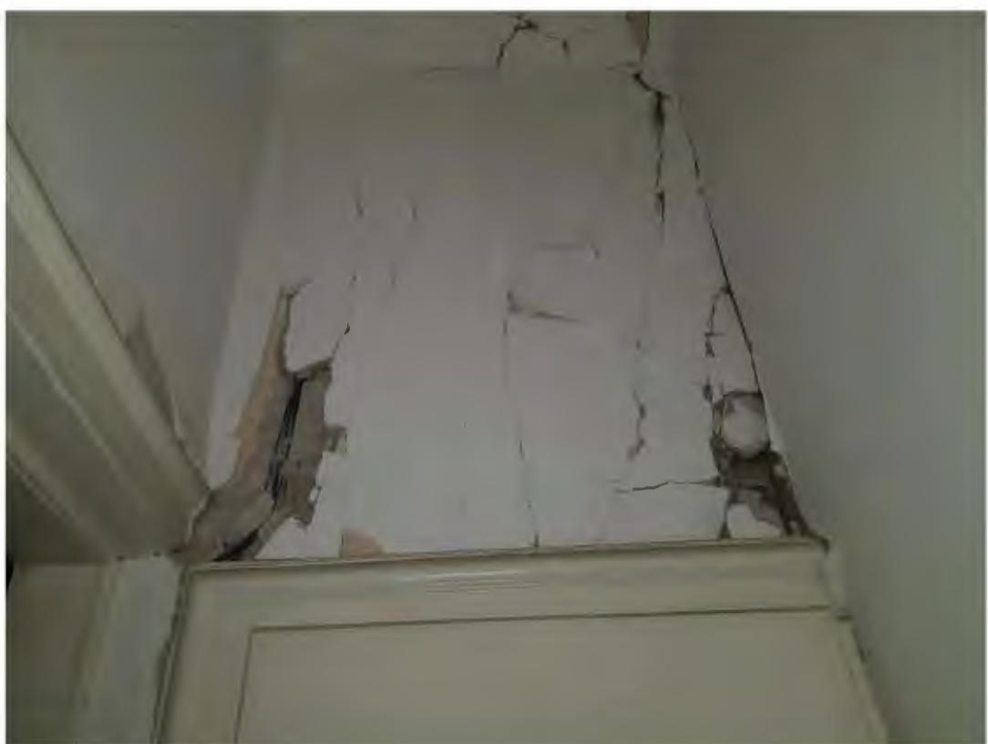
Slika 26. Oštećenja na zidovima unutar hodnika na katu
