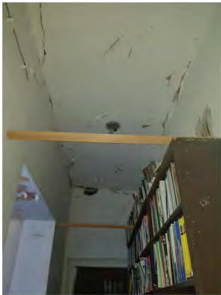
Slika 25. Vlaga i oštećenja na zidovima i stropu unutar hodnika na katu
