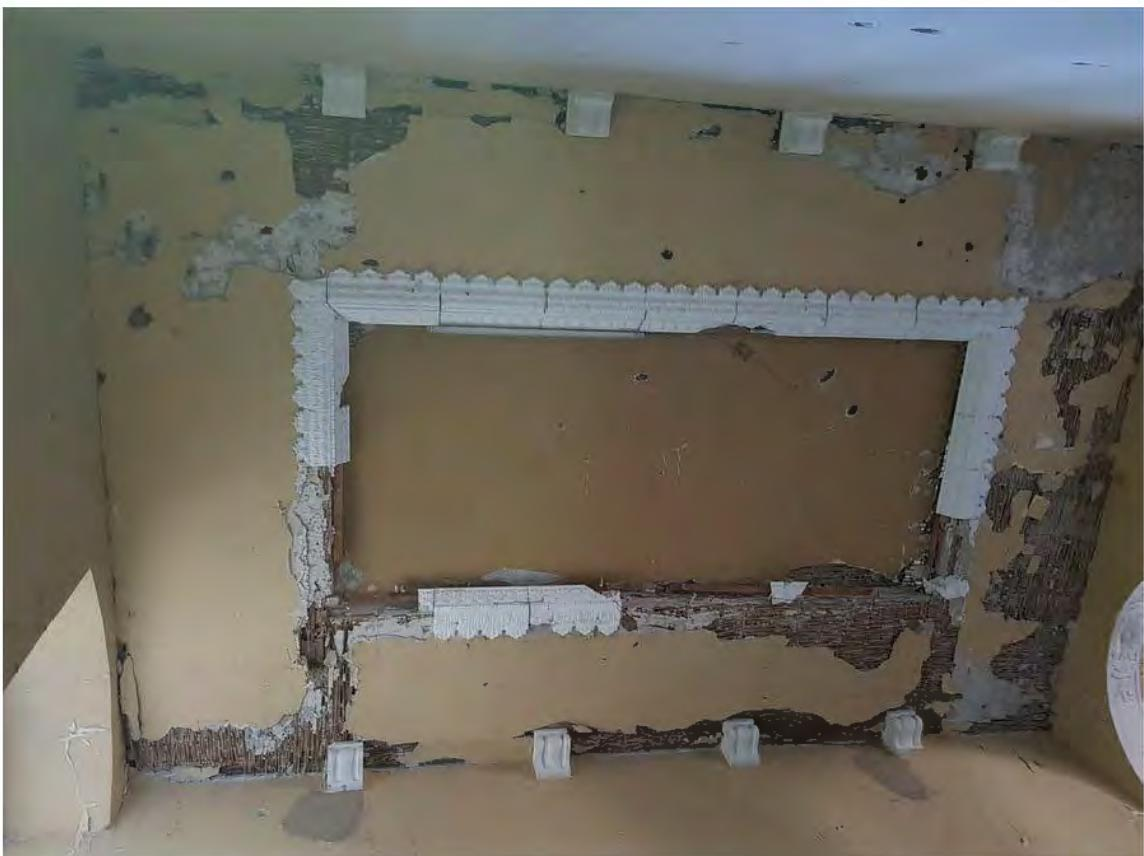
Slika 14. Oštećenja na stropu stubišta između prizemlja i kata
