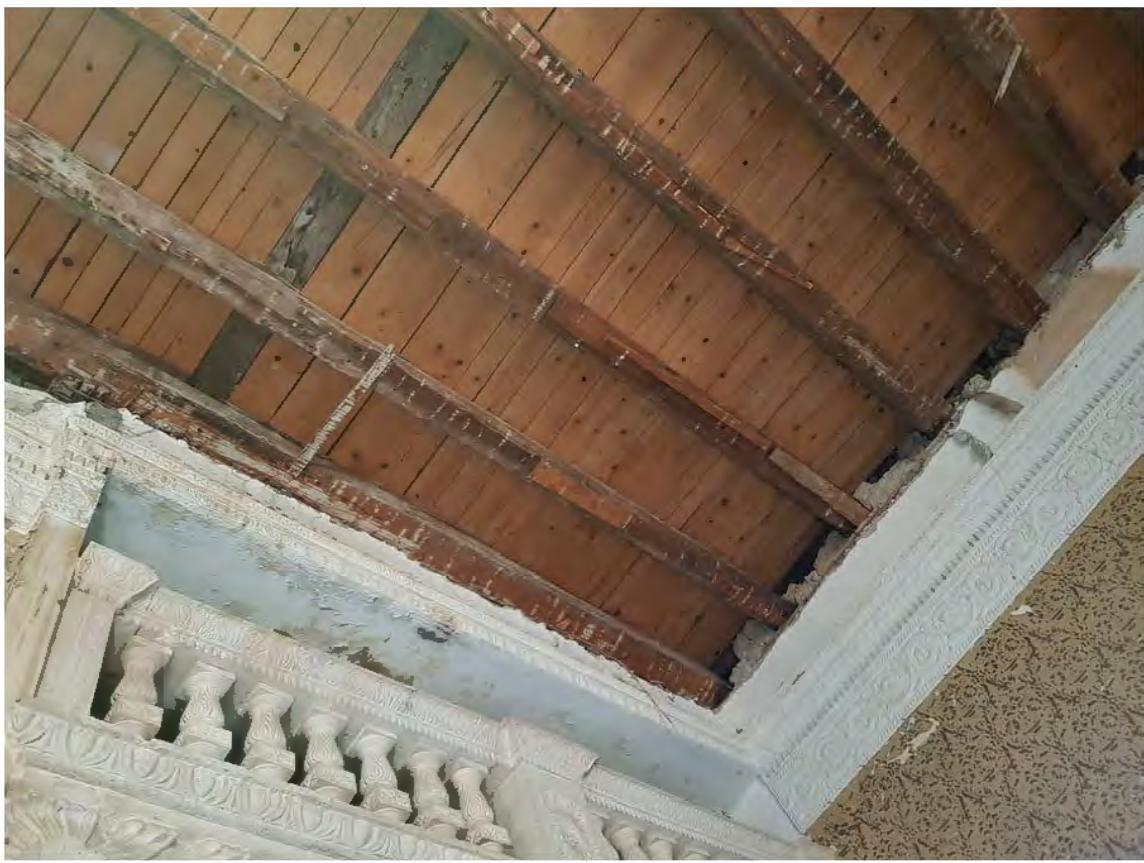
Slika 17. Oštećenja na nosivoj krovnoj konstrukciji unutar salona na katu
