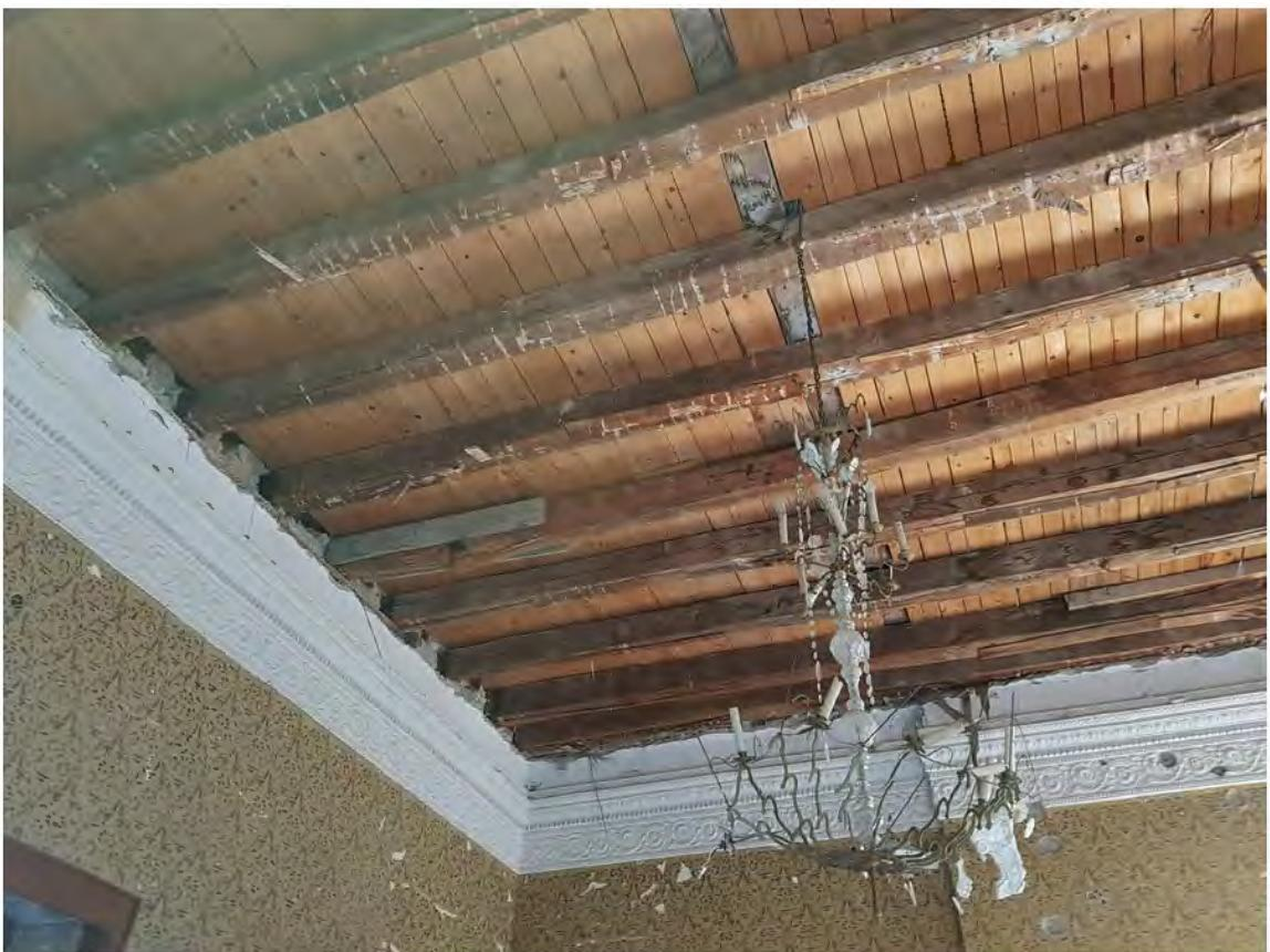
Slika 16. Oštećenja na nosivoj krovnoj konstrukciji unutar salona na katu
