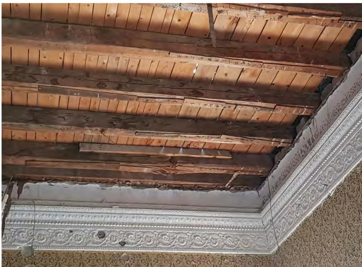
Slika 20. Oštećenja na nosivim drvenim gredama unutar salona na katu
