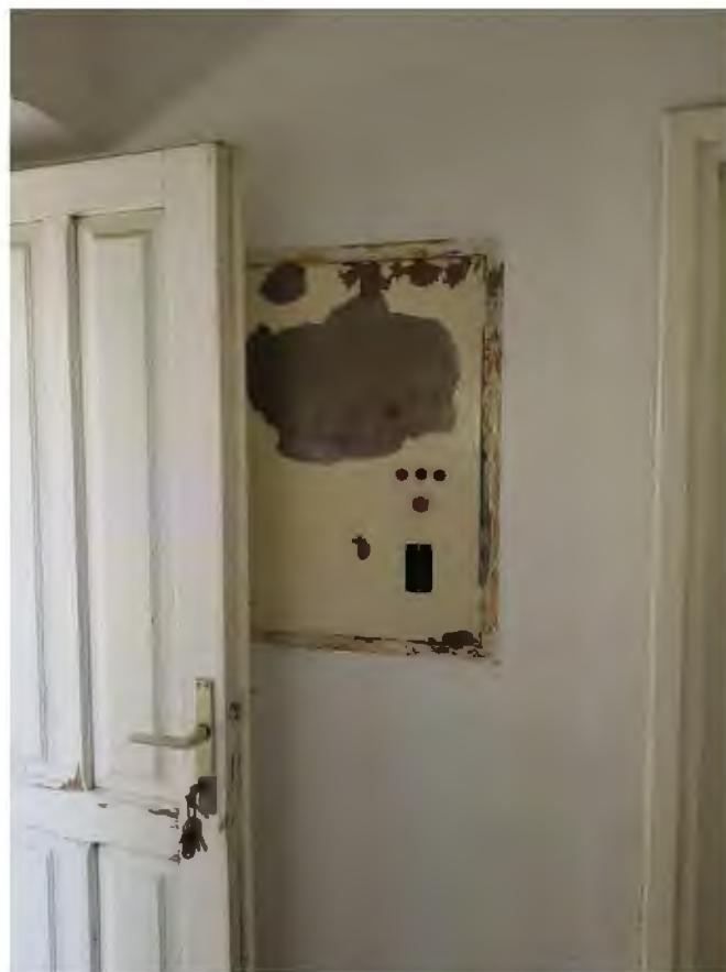
Slika 33. Vlaga na glavnom ormaru električne razdiobe unutar gospodarske zgrade
