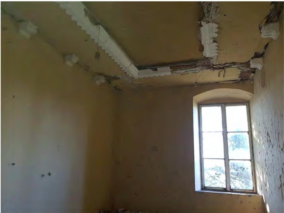
Slika 13. Vlaga i oštećenja na zidovima i stropu stubišta između prizemlja i kata
