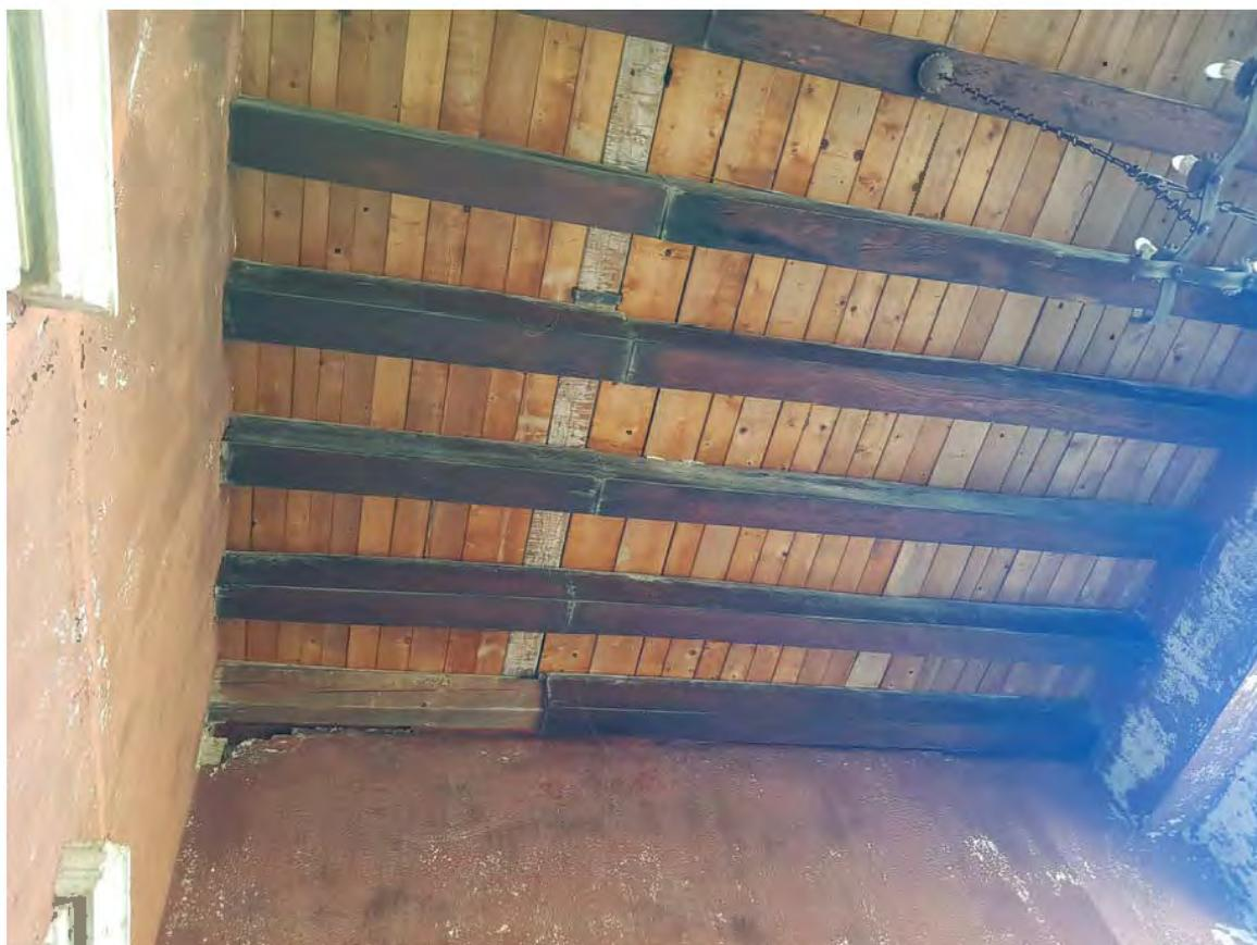
Slika 30. Oštećenja na stropnoj/krovnoj konstrukciji lođe na katu
