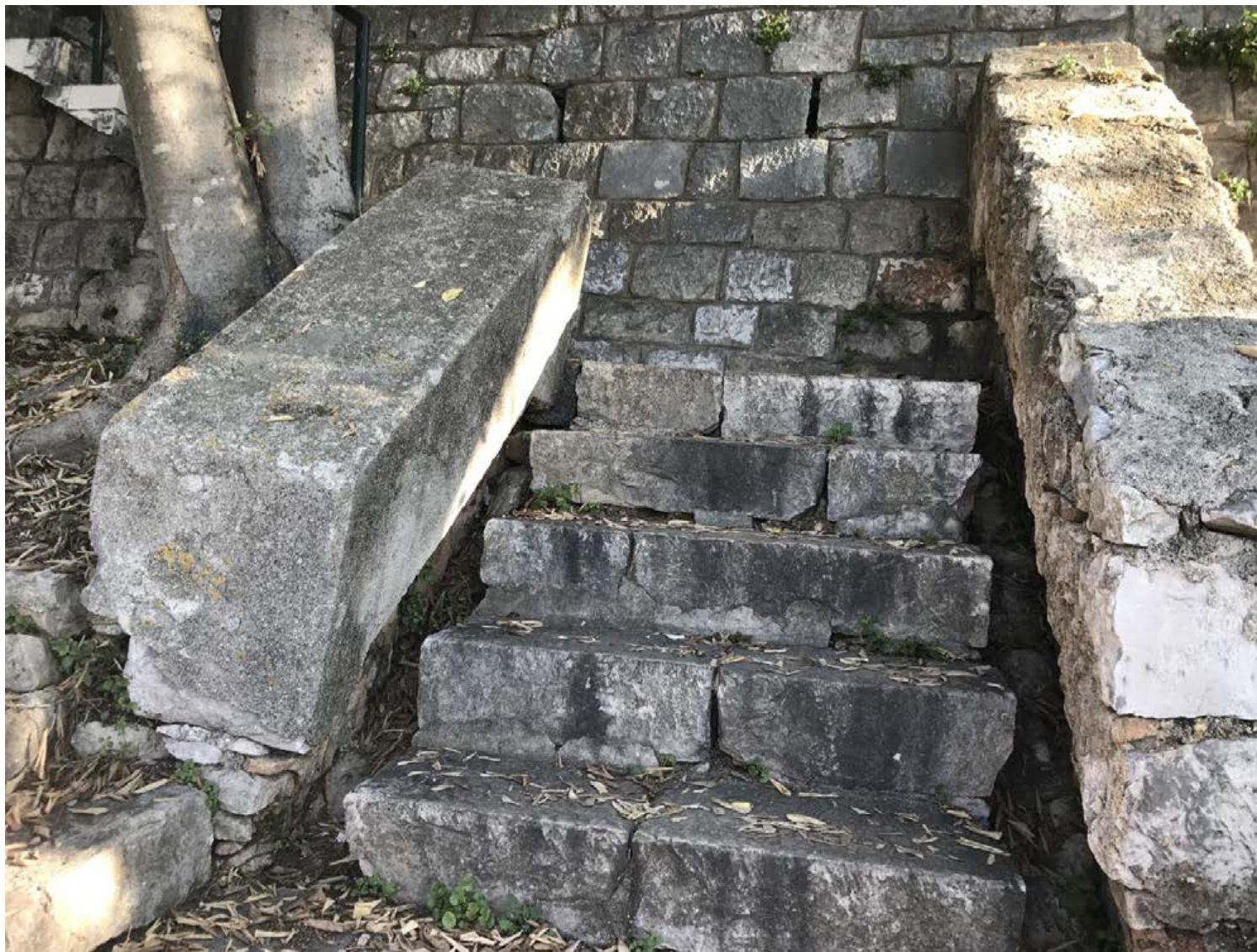
Fotografija 10. Postojeće stanje stubišta s podestima (prostori "ispod Boninova", B1 podzona)
