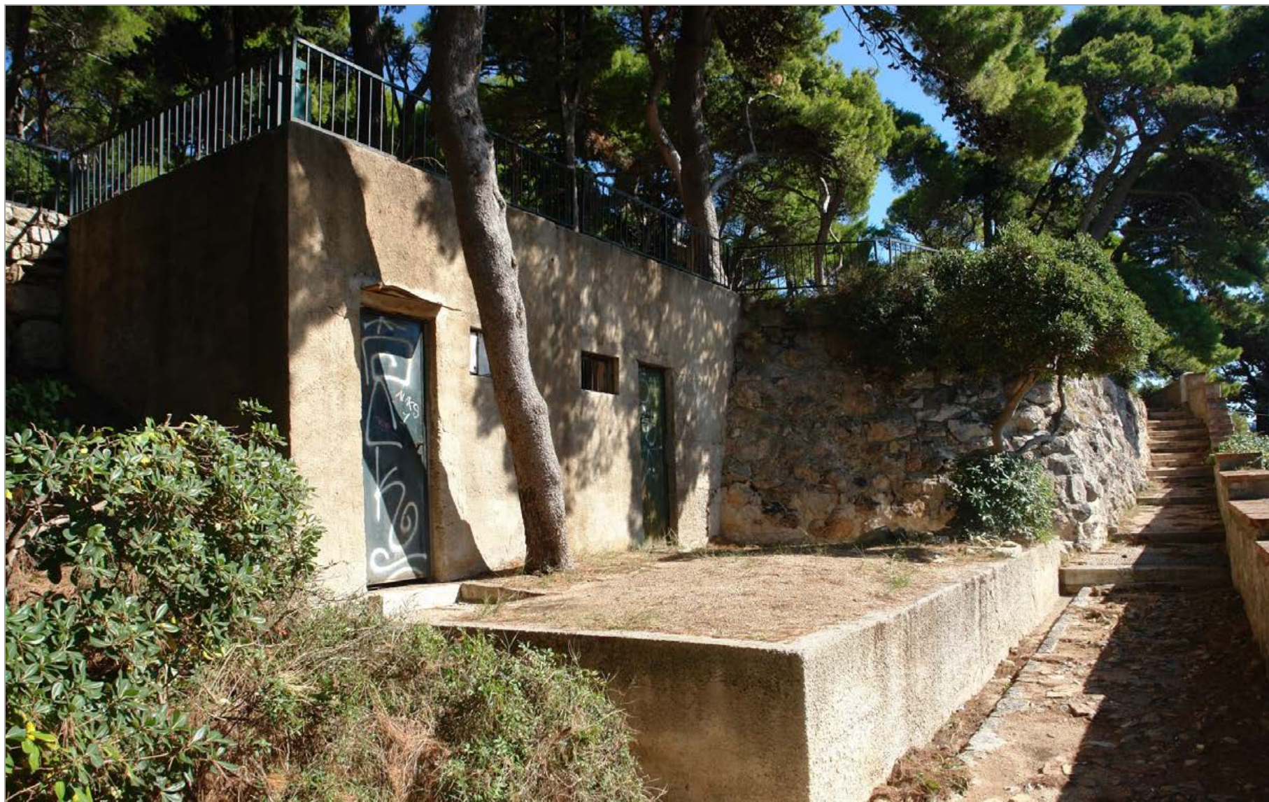
Fotografija 7. Građevina javnog toaleta na južnoj šetnici
