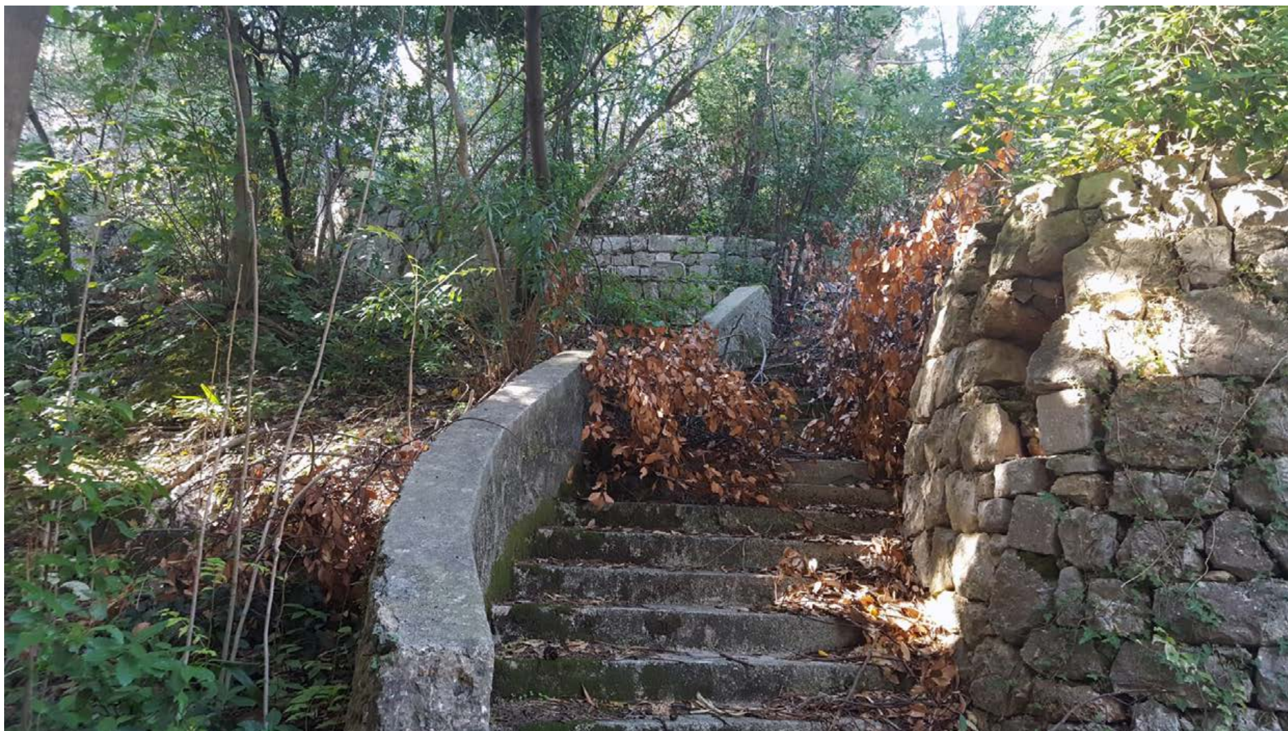
Fotografija 23. Zapuštena šetnica na začelju IUC-a (B3 podzona) koja vodi do A zone natječaja za realizaciju
