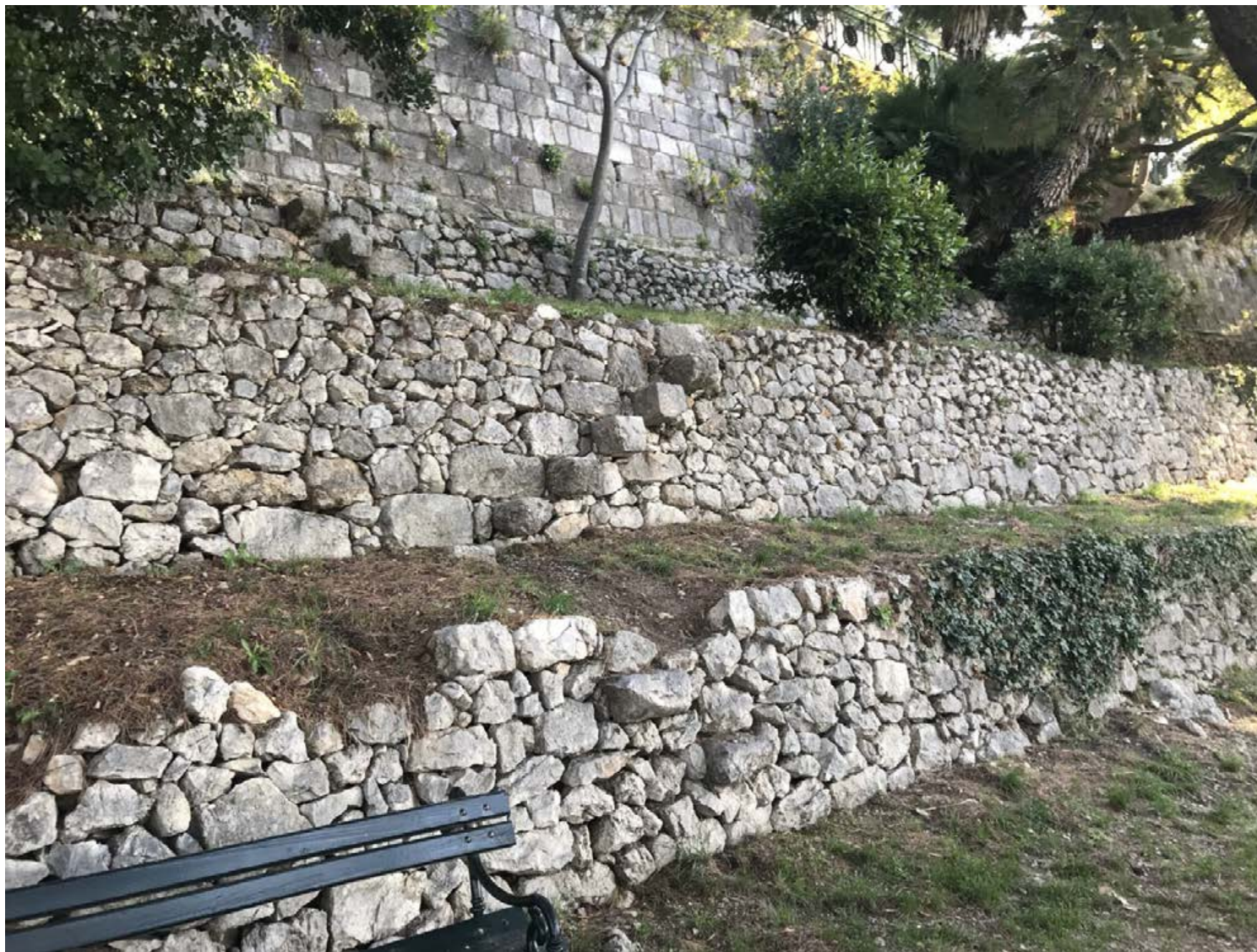
Fotografija 11. Suhozidne strukture na prostorima „ispod Boninova“ (B1 podzona)
