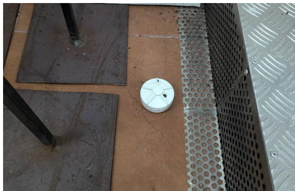
Slika 23: Alarm za dojavu vode – preventivna mjera zaštite od poplava
