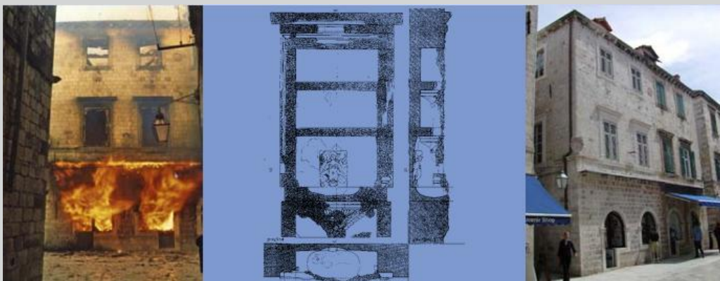
Slika 5: Primjer ratnog oštećenja zgrade Sigurate 2, i obnove objekta izvedene 1995.–1999.
