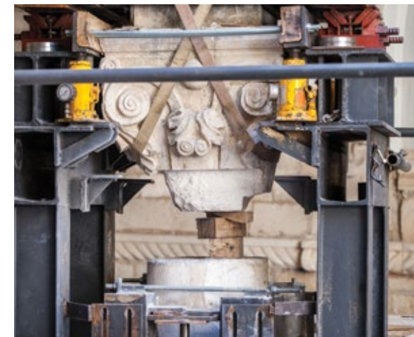
OBNOVA KAPITELA U KNEŽEVOM DVORU Izvor: Zavod za obnovu Dubrovnika
