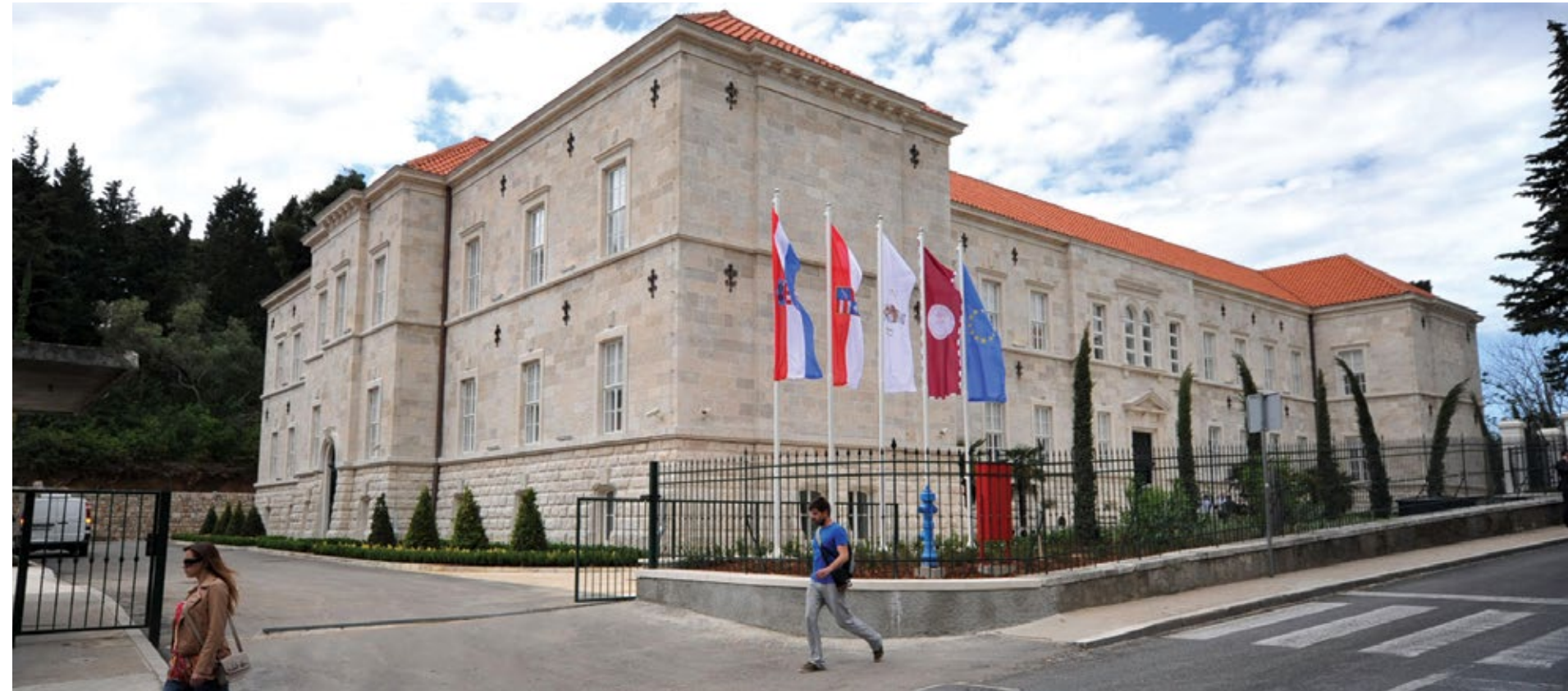
ZGRADA SVEUČILIŠTA U DUBROVNIKU Izvor: Sveučilište u Dubrovniku
