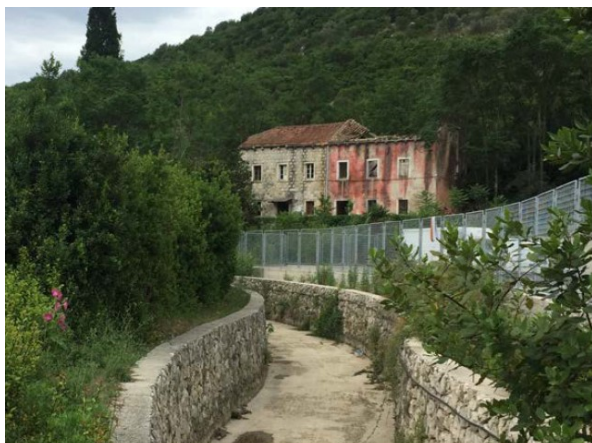
Slika 10. Regulacija korita povremenog bujičnog vodotoka Slavjan u donjem i gornjem dijelu obuhvatu UPU-a (Izvor: Krajobrazna studija, Zelena infrastruktura d.o.o., 2018.)
