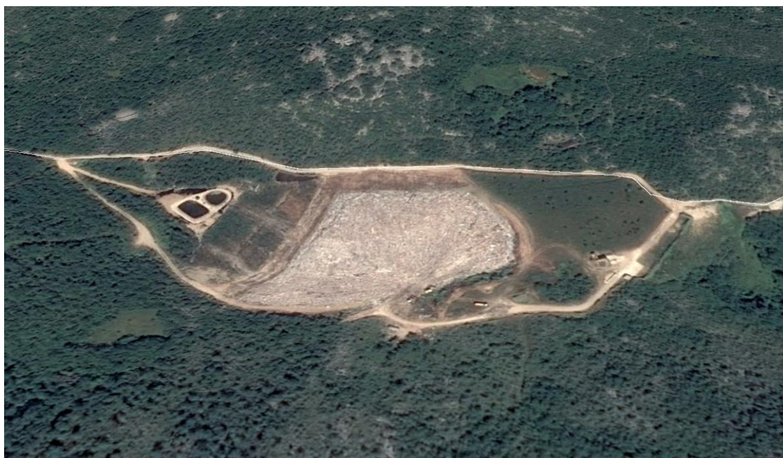
Slika 6.5.2.2.-1.: Ortofoto prikaz lokacije odlagališta Grabovica (Izvor: Geoportal)
