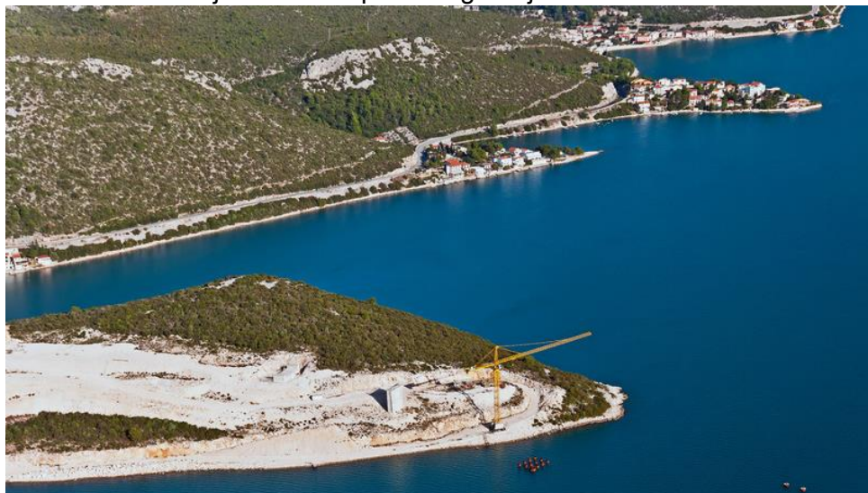
Slika 9. Pelješki most – početak gradnje
