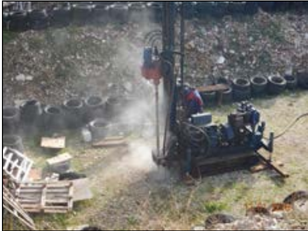
Slika 3.1: Bušenje upojne bušotine B-1 na lokaciji budućeg postrojenja
