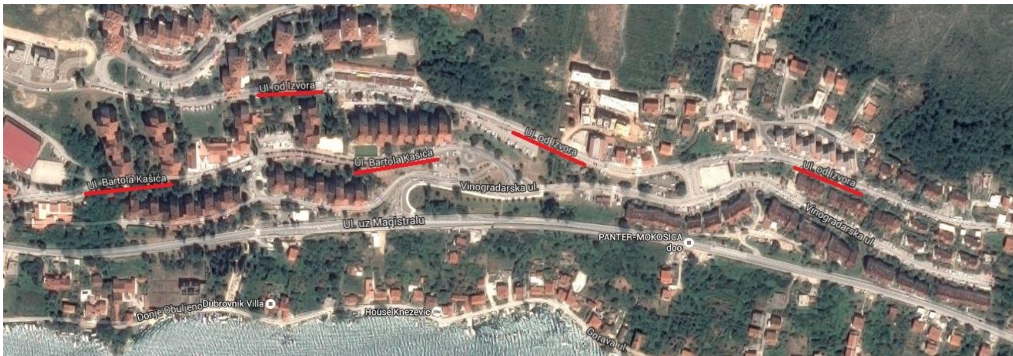
Slika 19. Područje Nove Mokošice ugroženo pojavom klizišta
