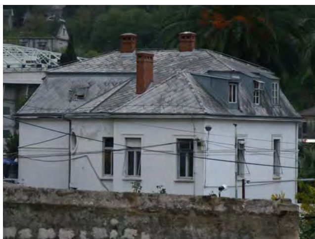
Krov danas, pogled sa sjevera (s limenim belvederima i recentnim dimnjacima)
